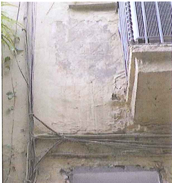
FOTOS 5-6. L'ELIMINACIÓ DE LES PINTURES SOBREPOSADDES A UNA FAÇANA RESULTA IMPRESCINDIBLE PER TAL DE PROCEDIR A LA SEVA RECUPERACIÓ I RESTAURACIÓ
