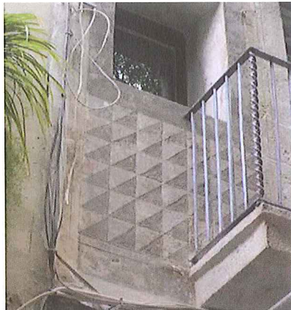
FOTOS 5-6. L'ELIMINACIÓ DE LES PINTURES SOBREPOSADDES A UNA FAÇANA RESULTA IMPRESCINDIBLE PER TAL DE PROCEDIR A LA SEVA RECUPERACIÓ I RESTAURACIÓ
