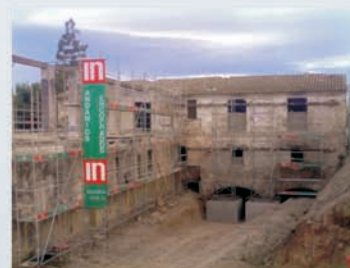
Edificio Policía Local en Valencia
