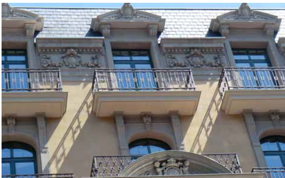
ELEMENTS DE FAÇANA REHABILITATS
