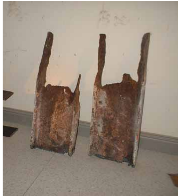
CAPS DE BIGA SENSE ÀNIMA EN ZONA DE RECOLZAMENT
