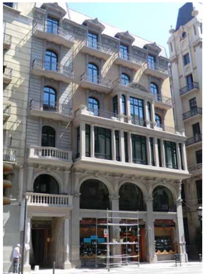
FAÇANA DE VIA LAIETANA REHABILITADA
