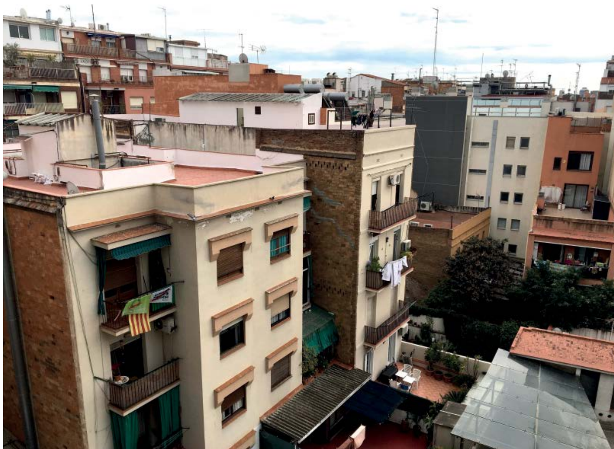
Les façanes posteriors dels edificis requereixen igualment d'intervencions de reparació i millora de l'eficiència energètica. Foto: Aina Gatnau
