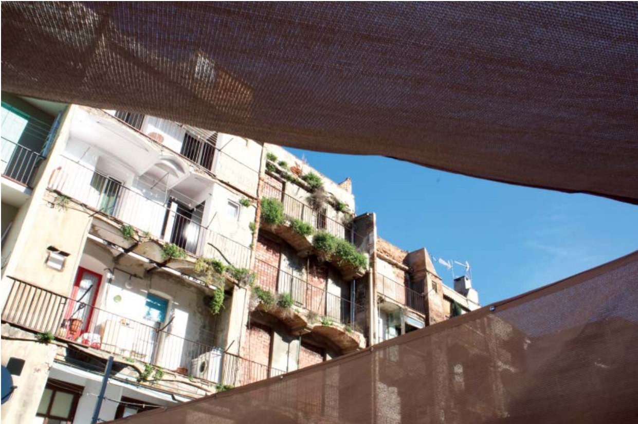
Els recursos limitats dels inquilins representen un fre a la necessària rehabilitació dels edificis d'habitatges. Foto: Aina Gatnau
