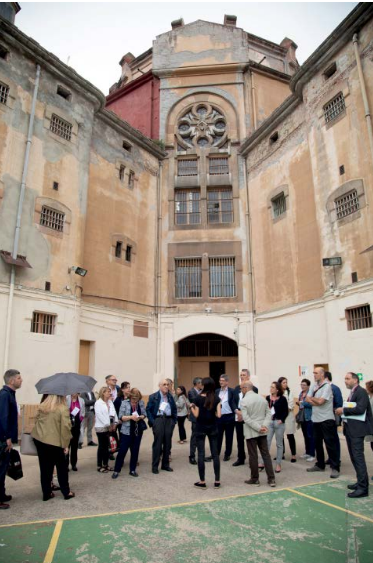
Els assistents a la jornada van poder visitar l'edifici de la Model que és objecte d'un ambiciós projecte de rehabilitació. Foto: Inma Alcario
