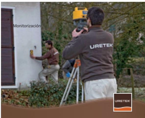
Figura 16. Monitorización del principio de levantamiento.
