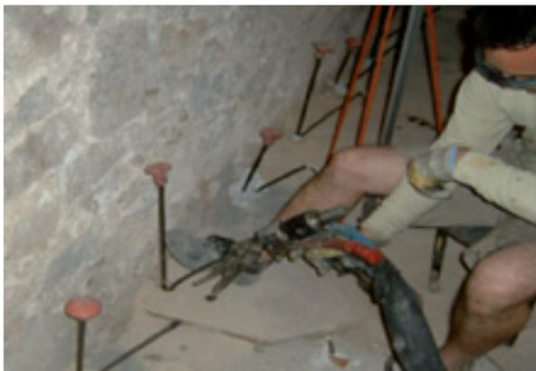
Figura 1. Inyección en zapata de cimentación.
