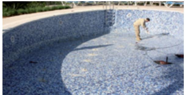
Figura 28. Consolidación y levantamiento de vaso de piscina de hasta 7 cm.
