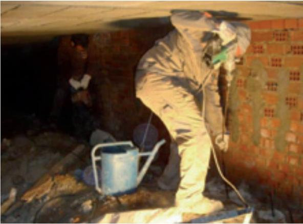
Figura 14. Trabajos de inyección con gálbulo reducido.
