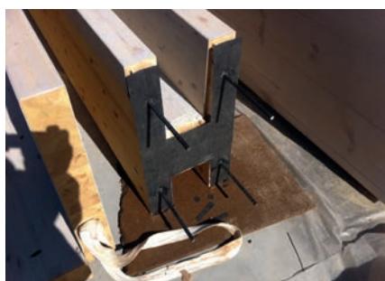
Atlètic Terrassa Pavelló de fitness: sistema d'unió de l'estructura de fusta i impermeabilització amb membrana de poliolefina termoplàstica (TPO)
