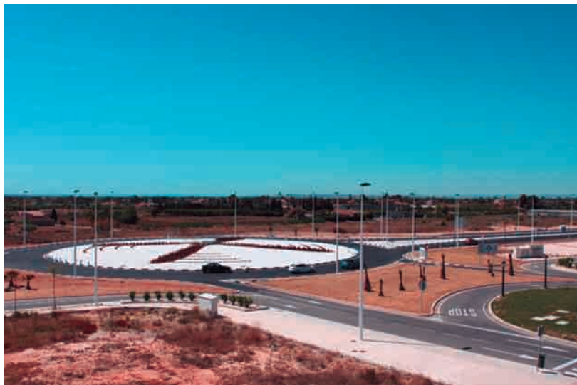
Figura 1. Tramo objeto de la DAP de Acciona en la carretera N-340, en el desdoblamiento a su paso por Elche.
