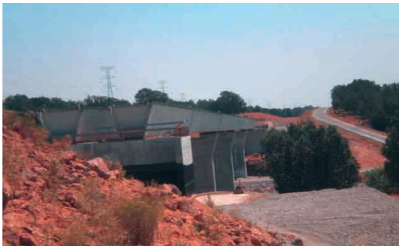
Figura 14. Fase de construcción del Viaducto Arroyo Valchano.
