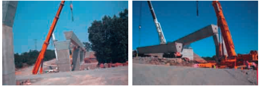
Figura 13. Fase de construcción del Viaducto Arroyo Valchano.
