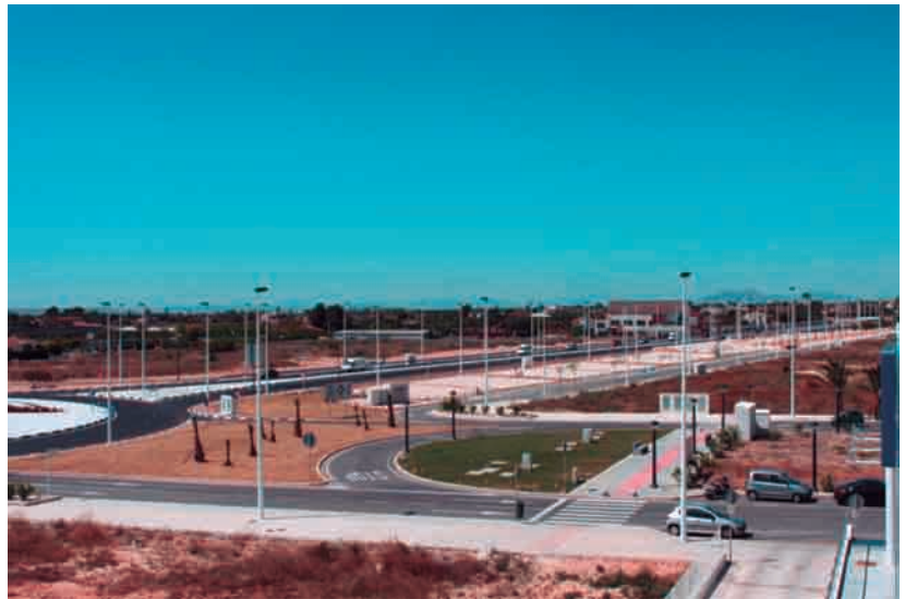
Figura 5. Detalle del desdoblamiento de la N-340 a su paso por Elche.
