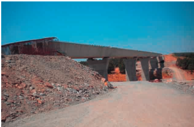
Figura 10. Viaducto Arroyo Valchano objeto de la DAP de Acciona, situado en el tramo del AVE Madrid-Galicia: Zamora-Lubián.
