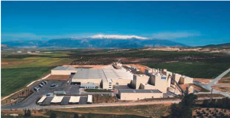
Figura 2. Nueva fábrica de placas de yeso laminado de la empresa Knauf en Granada donde se produce la nueva placa Knauf STD-neutral CO 2 .
