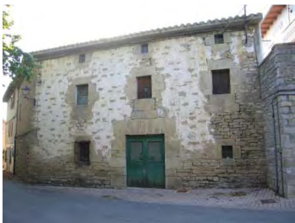
CASES RURALS, NAVARRA PROJECTE: BOA ARQUITECTOS DISSENY PH: BOA ARQUITECTOS Y ENERGIEHAUS INSTAL·LACIONS: PROGETIC
