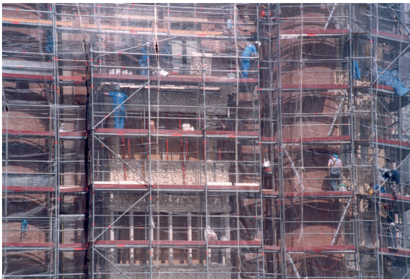
Rehabilitació d'un edifici històric al centre de Barcelona (Foto Chopo)
