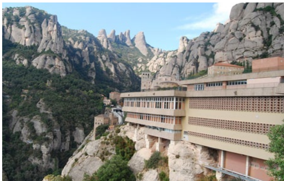
CAS PENDENT DE RESOLDRE: AQUEST ENORME RESTAURANT S'HA GASTAT UN PRESSUPOST MOLT ELEVAT EN LA DARRERA RESTAURACIÓ EN LA SEVA ADAPTACIÓ INTERIOR. OBSERVI'S LA MANCA D'INTEGRACIÓ DE L'EXTERIOR DE L'EDIFICI I L'IMPACTE VISUAL QUE AQUESTA GENERA
