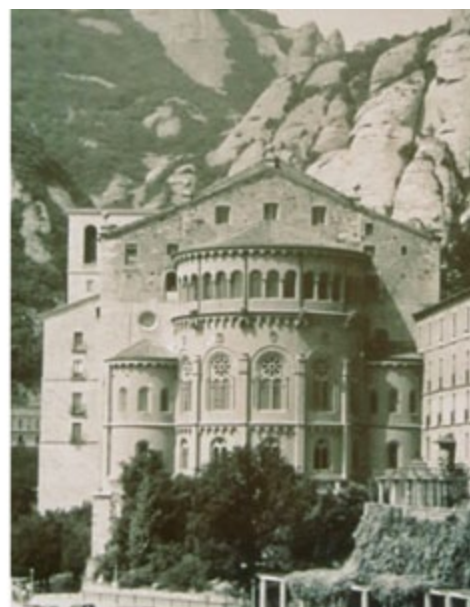
COMPARACIÓ DE LA FAÇANA POSTERIOR DE LA BASÍLICA ABANS (1850) I DESPRÉS DE LA INTERVENCIÓ (1910) DELS ARQUITECTES VILLAR CARMONA (PARE I FILL), QUE VAN AFEGIR TRES ABSIS SEMICIRCULARS D'ESTIL NEOROMÀNIC I VAN MODIFICAR EL PENDENT I L'ALÇADA DE LES COBERTES AFEGINT UN NIVELL EXTRA A LA COBERTA. AQUESTS AFEGITS VAN PROVOCAR LA DESPROPORCIÓ AL VOLUM ORIGINAL DE LA BASÍLICA
