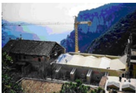
ABANS I DESPRÉS DE LES OBRES DE RECONSTRUCCIÓ DE LA COBERTA (1994). S'APRECIEN ELS CONTRAFORTS, ÒCULS I CIMBORIS RESCATATS
