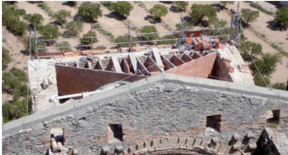
REHABILITACIÓ DE LA COBERTA DE LA CÚPULA CENTRAL AMB LA RECONSTRUCCIÓ DE TEULA ÀRAB
