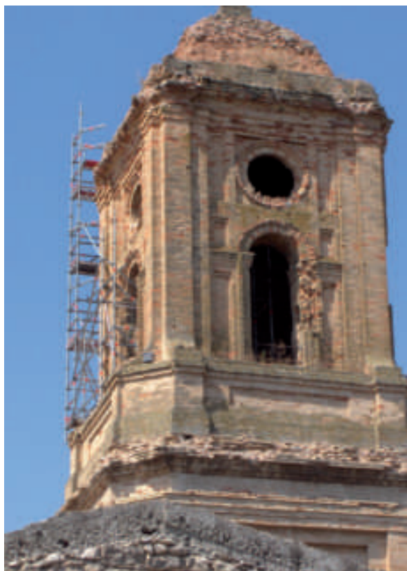
TORRE DEL CAMPANAR
