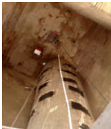
GRAPAT DE L'ESCALA DE CARGOL D'ACCÉS AL CAMPANAR AMB FIBRES DE CARBONI I ACABAT AMB ESTUC DE CALÇ
