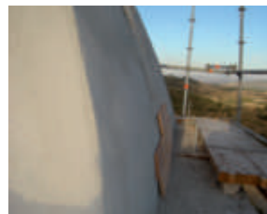
REPARACIÓ DE BARANA D'ESCALA AMB ELEMENTS CERÀMICS I MORTER DE CALÇ
