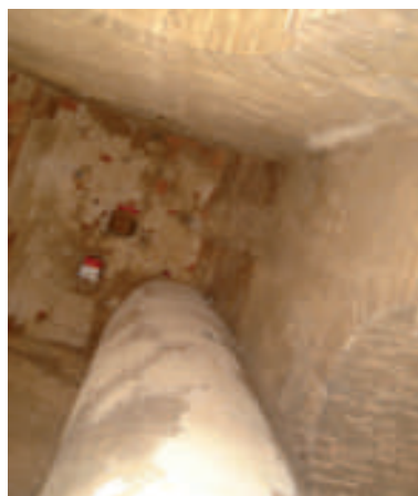
GRAPAT DE L'ESCALA DE CARGOL D'ACCÉS AL CAMPANAR AMB FIBRES DE CARBONI I ACABAT AMB ESTUC DE CALÇ
