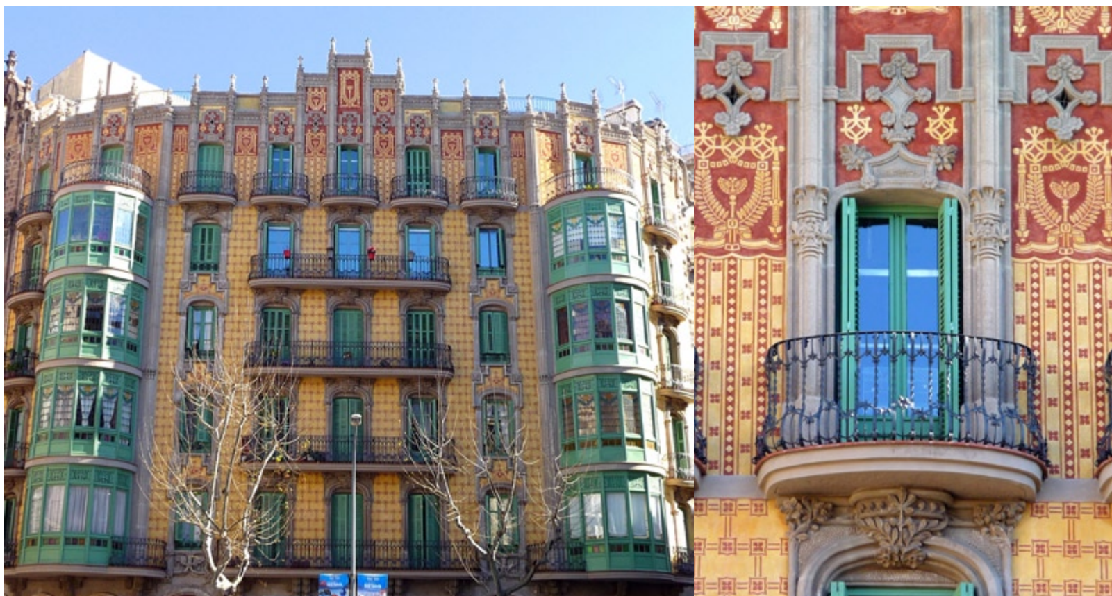
LA RESTAURACIÓ D'UNA FAÇANA HISTÒRICA REQUEREIX LA COMBINACIÓ DE TÈCNiques CONSTRUCTIVES TRADICIONALS (ESTUCS I TINTS) COMBINADES AMB ALTRES D'INNOVADORES (REFORÇOS ESTRUCTURALS), PERÒ PER DAVANT DE TOT REQUEREIX D'UNA SENSIBILITAT DE TOTS ELS PARTICIPANTS. C./ARIBAU, 180. NOTA 1
