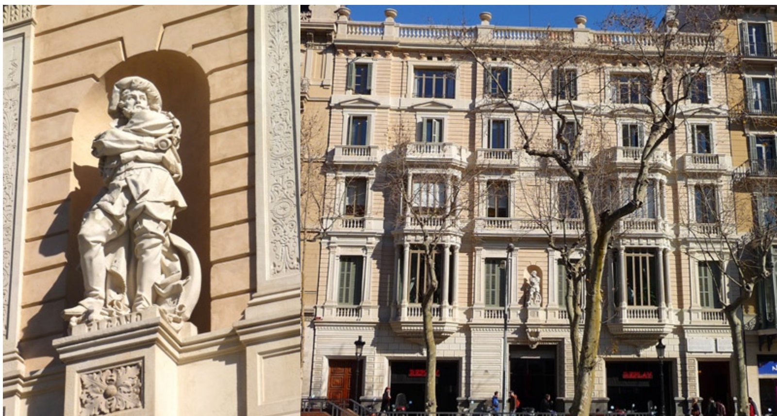
UNA FAÇANA DEL PASSEIG DE GRÀCIA ON UNA CAPA DE PINTURA, COL·LOCADA SOBRE L'ESTUC ORIGINAL I LA PEDRA, PROVOCAVA PATOLOGIES GREUS. ELCANO VETLLA TRANQUIL LA MORDA DESPRÉS DE RECUPERAR LA DIGNITAT DE LA PEDRA I LA CALÇ. NOTA 3
