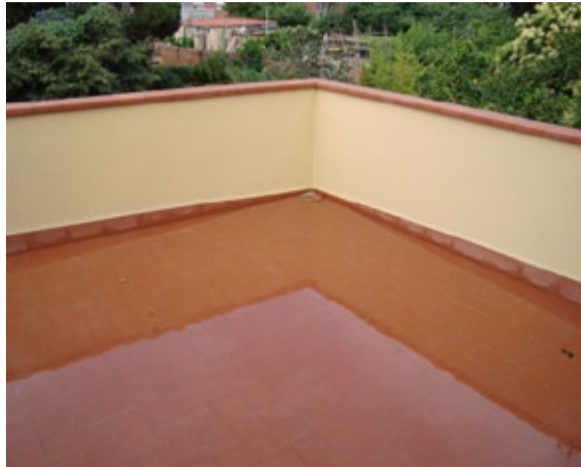
PROVA D'ESTANQUEITAT DE LA LÀMINA DE IMPERMEABILITZACIÓ SOTA SOLERA I POSTERIOR PROVA D'ESTANQUEITAT DE LA COBERTA CERÀMICA
