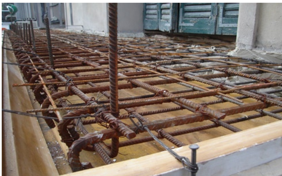
ESTRUCTURA PER A NOVA LLOSA DE FORMIGÓ ARMAT DE BALCÓ CORREGUT BALUSTRAT. MOMENT DE LA INSPECCIÓ DE LES ARMADURES I LA SEVA CORRECTA CONNEXIÓ AL SUPORT, PREVI A L'AUTORITZACIÓ DEL FORMIGONAT. FOTOGRAFIA DEL DOSSIER DE REGISTRE DE L'ACTA D'OBRA PERTINENT. OBRA AL CARRER NIL FABRA, EXECUTADA PER TRAC L'ANY 2009
