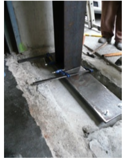
EN LES ACTUACIONS DE REFORÇ ESTRUCTURAL AMB ELEMENTS DE FERRO CAL TENIR ESPECIAL CURA A L'HORA DE VALIDAR LES SOLDADURES I, EN CAS DE DUBTE, DEMANAR LES PROVES ADIENTS DE CONFIRMACIÓ DE LA QUALITAT DE LES MATEIXES A UN LABORATORI QUE LES PUGUI CERTIFICAR. OBRA EN CURS A VIA LAIETANA, EXECUTADA PER TRAC L'ANY 2009
