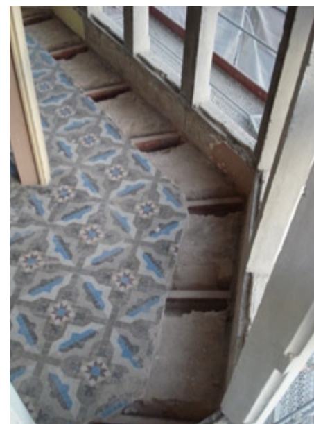
FASE FINALITZADA DE SANEJAMENT DE CAPS DE BIGA DE FERRO DE LLOSA DE TRIBUNES A FINCA DE L'EIXAMPLE, EN L'ESTAT PREVI A LA VISITA D'OBRA PER VALIDAR EL REPICAT I AUTORITZAR A INICIAR LA FASE DE PASSIVAT O OXISATURACIÓ DE LES BIGUES. OBRA AL CARRER BAILEN, EXECUTADA PER TRAC L'ANY 2008
