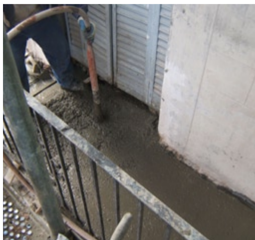
VIBRAT DEL FORMIGÓ D'UNA LLOSA DE FORMIGÓ I PROVETA PREPARADA PER ENVIAR A LABORATORI PER TAL DETERMINAR LA QUALITAT DEL MATERIAL FABRICAT A OBRA. OBRA EXECUTADA PER TRAC L'ANY 2009
