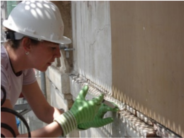
INJECCIÓ DE PLM A PLAQUES D'ESTUC PER TAL DE FIXAR-LES DE NOU AL SUPORT. LA DENSITAT DEL MATERIAL D'INJECCIÓ ESTÀ CALIBRADA A LES NECESSITATS DE CADA SITUACIÓ. OBRA AL CARRER CARMÉ, EXECUTADA PER TRAC L'ANY 2008
