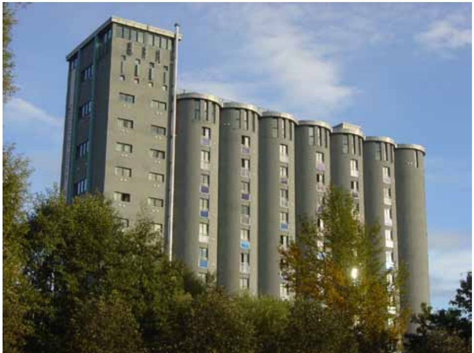
LAPOSTA SOSTENIBILISTA D'UN PAÍS COM NORUEGA ELS VA PORTAR A LA REHABILITACIÓ D'UNES SITGES DE CEREALS EN DESÚS PER FER-HI UNA RESIDÈNCIA UNIVERSITÀRIA ALTAMENT EFICIENT ENERGÈTICAMENT
