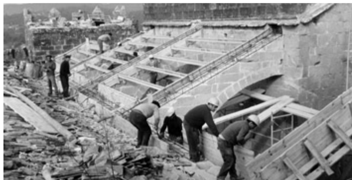
CATEDRAL DE TUI, REPOSICIÓ D'UNA NOVA COBERTA AMB CÈRCOL I FORMIGÓ ARMAT EN VOLTES DEL TRANSEPTE, COMBORI, CAPELLES I NAUS DEL CREUER. PER DAMUNT COM ACABAT FINAL AMB TEULA ÀRAB.
