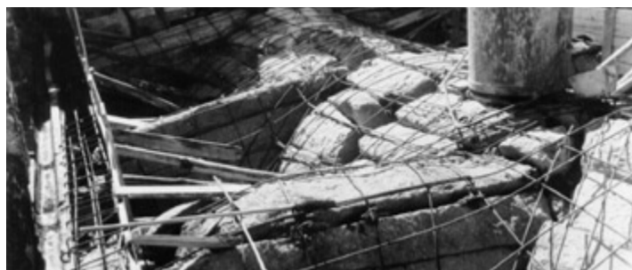
CATEDRAL DE TUI, PONTEVEDRA, 1965-72. PONS SOROLLA. CONSOLIDACIÓ DE LES VOLTES DEL CLAUSTRE. INTRODUCCIÓ DE CÈRCOL EN ELS MURS DE LA NAU CENTRAL, EN EL CREUER I ABSIS. SEGUINT ELS CRITERIS D'INTERVENCIÓ DELS ANYS SETANTA DEL LLIBRE RUINAS EN CONSTRUCCIONES ANTIGUAS .
