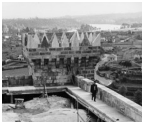
CATEDRAL DE TUI, 1965. VISTA DEL FORMIGÓ EN LES VOLTES DEL CLAUSTRE.
