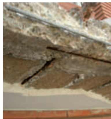
PATOLOGIA MOLT AMAGADA DESCOBERTA EN UNA OBRA EN CURS EN UNA FINCA CONTEMPORÀNIA AL BARRI DE SANT GERVASI DE BARCELONA
