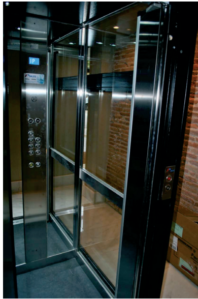
Instal·lació d'ascensor en edifici existent
